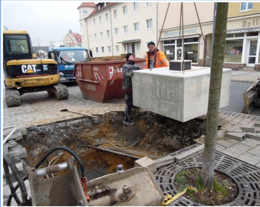
Fertigfundament wird versetzt
