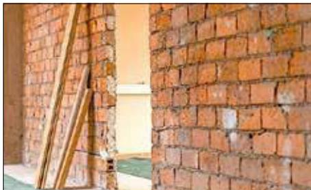
Decken- und Wanddurchbrüche sowie Putzarbeiten erfolgen parallel, um Synergieeffekte zu nutzen.
