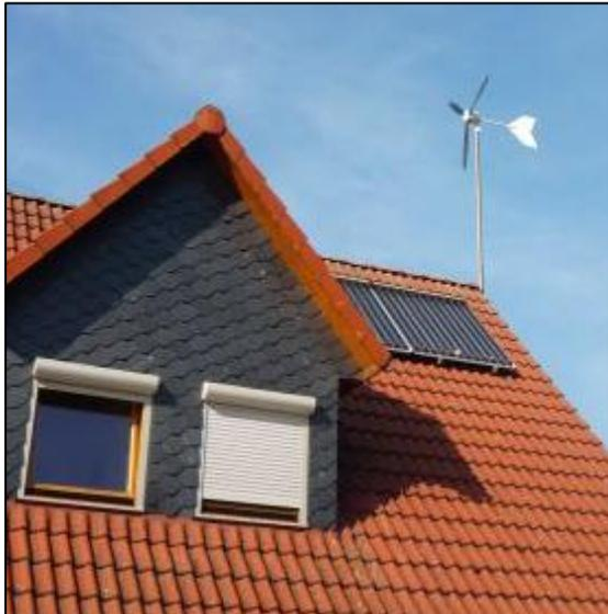
Bild 17: Klein-Windkraftanlage (Quelle:[17])
