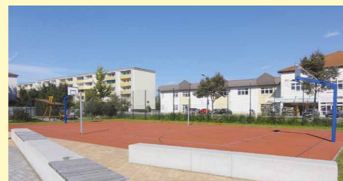
Die Freizeitsportanlage nach ihrer Fertigstellung –
